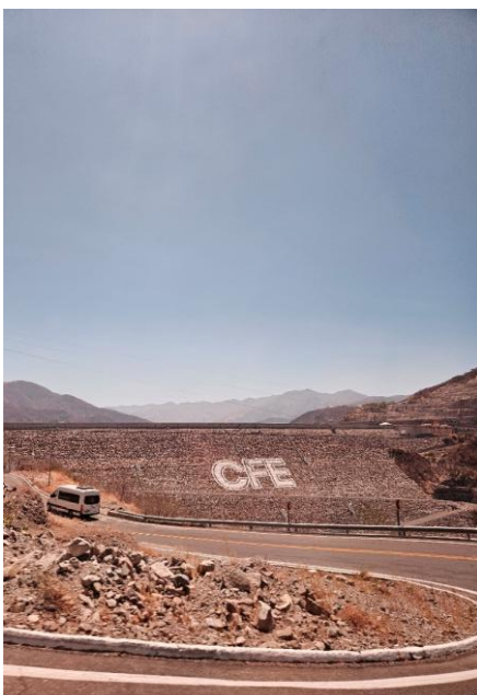
La Yesca Dam från nedströmssidan
