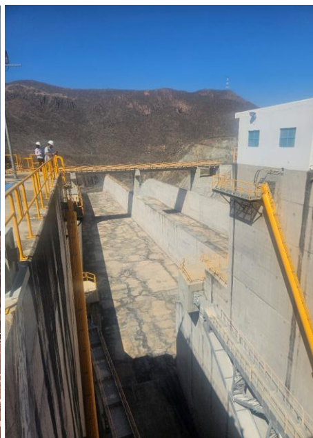
Utskovet där dammens stora dimensioner blir tydliga.
